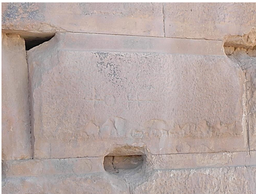
هیچ منطقی قبول نمی‌کند که قرار دادن بست‌های آهنی در این سوارخ‌های سطحی ایجاد شده در سنگ موجب استحکام بنای آن باشد.
