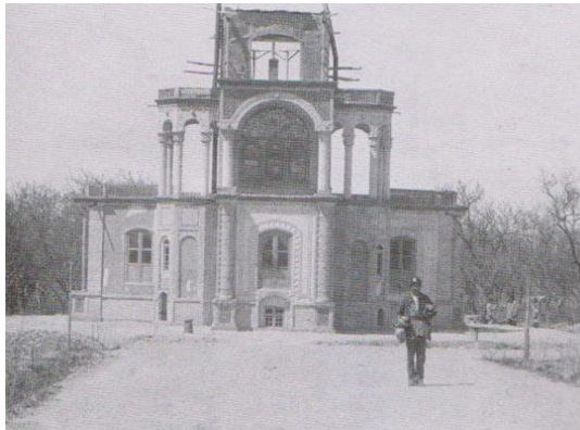
کلاه فرنگی کوچک در حال ساخت! باغ شمال، ۱۲۷۷ شمسی
