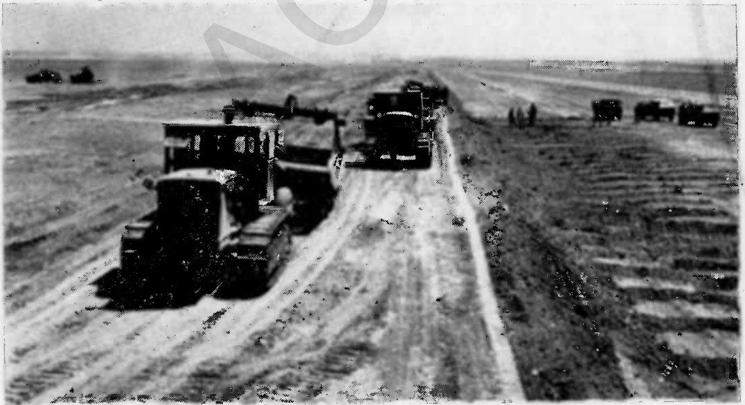
د دل آرام او گرشک ترمنځ د مارگي د دښتې سرک چه د قیر اچولو دپاره هموار یزی .
