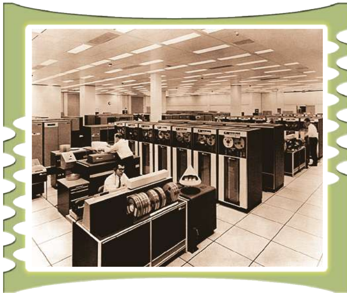
۱۰-۱ شکل د یو IBM ډوله لوی کمپیوتر انځور گورئ
