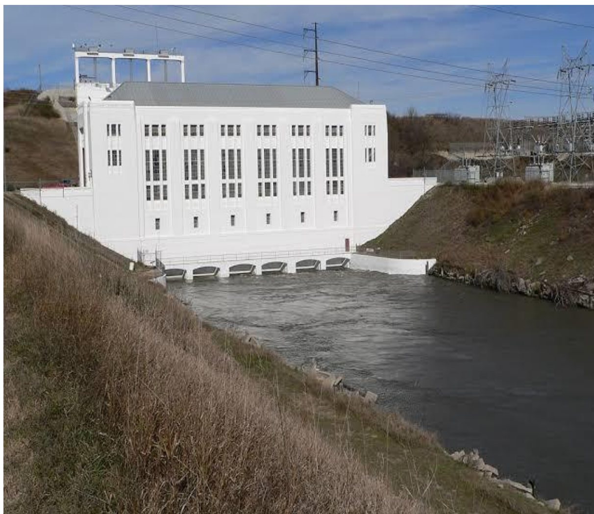
4.7 انځور: خروجي کانال (Tailrace Canal)
