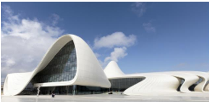
د حیدر علی ایف تجارتي مرکز (باکو - آذربایجان) معماری طرحه: زها حدید
