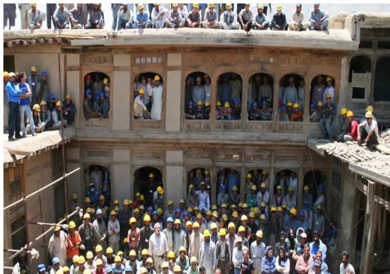
عکس یکی از خانه ها در جریان باز سازی
