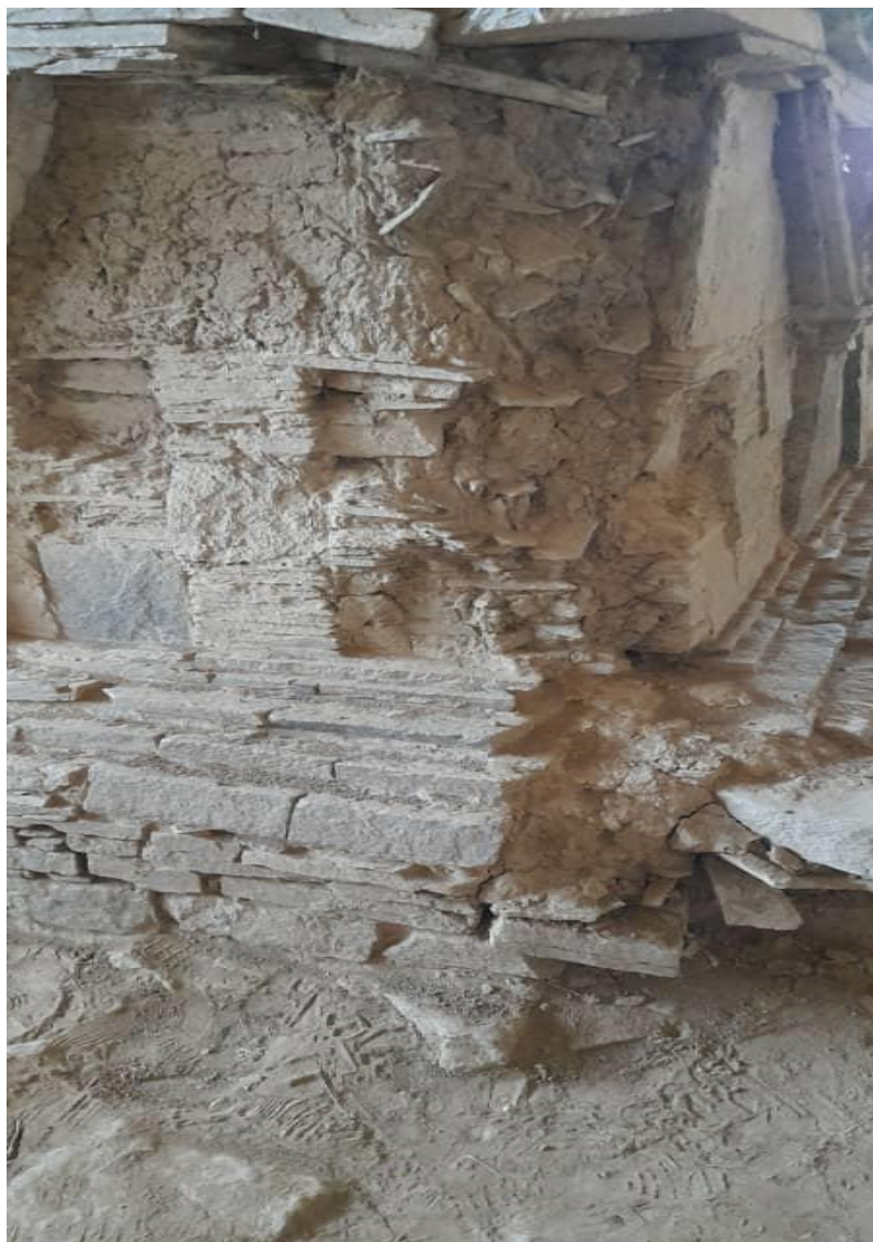
تصویر بخشی از استوای منطقه مس عینک
