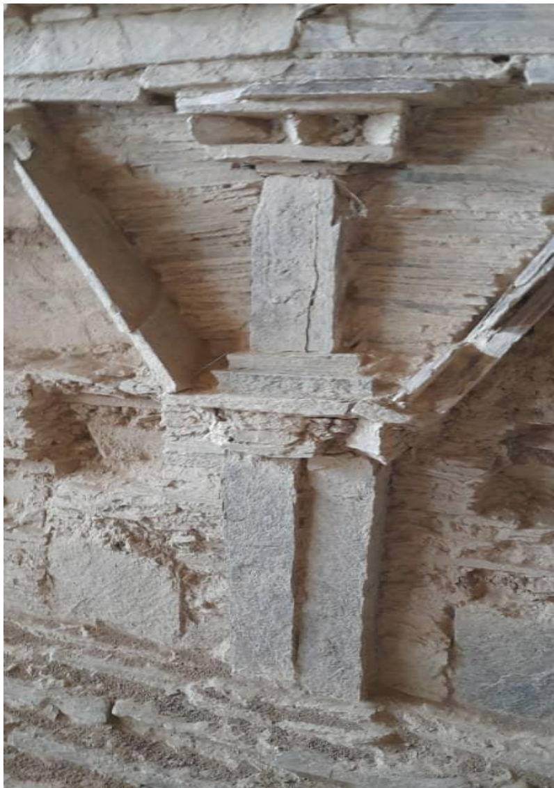
تصویر بخشی از استوای منطقه مس عینک
