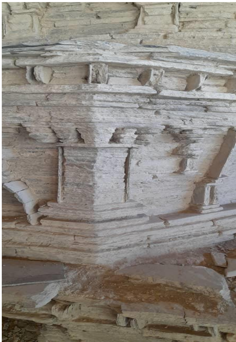
تصویر بخشی از استوپیای منطقه مس عینک
