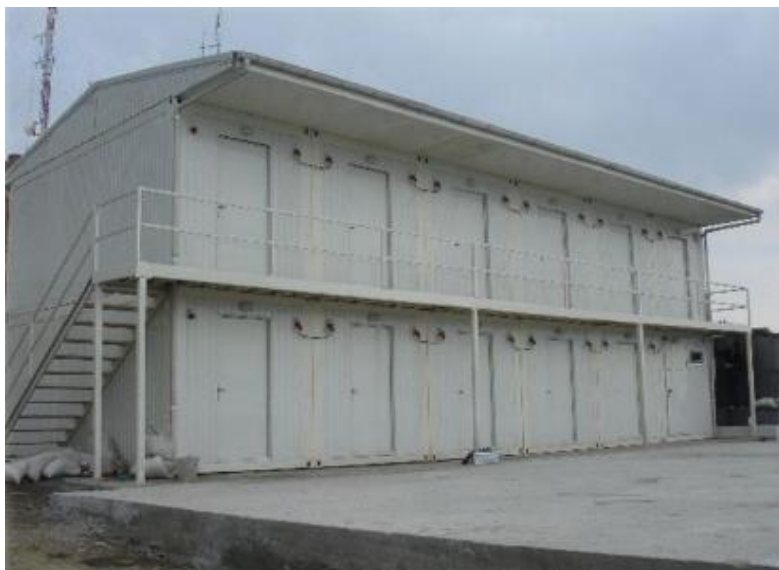
تصویر از ساختمان دو منزله کانتینری تی آی ام
