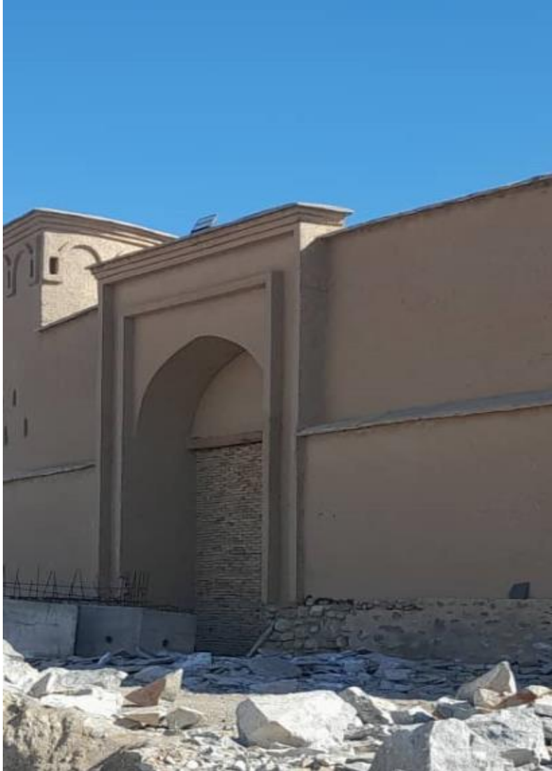
تصویری از قسمت دروازه عمومی غربی قلعه
