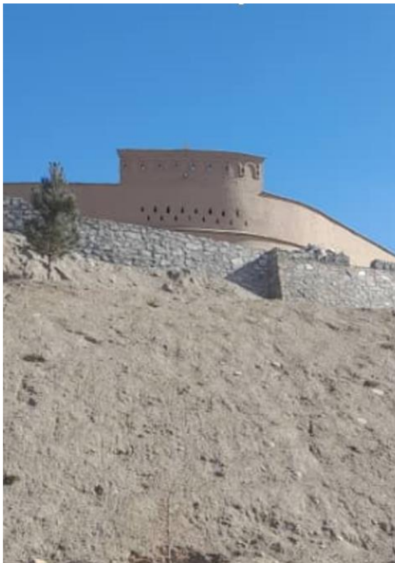
تصویری خارجی از دیوار احاطه قلعه بلند
