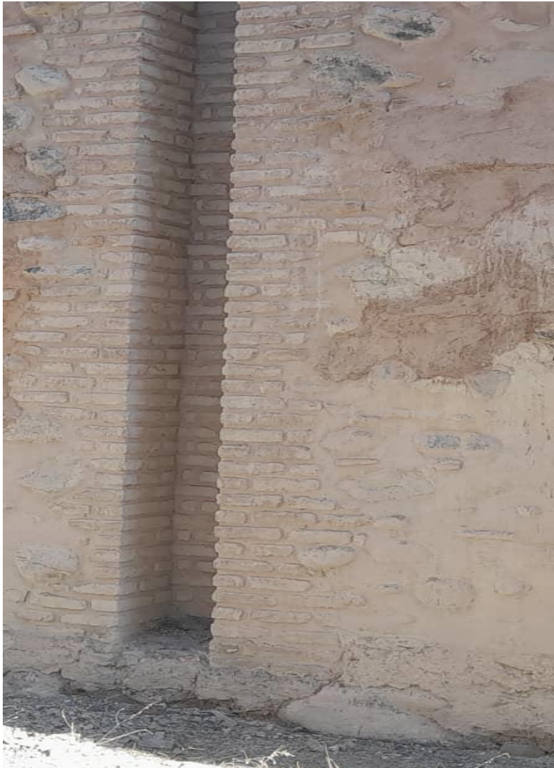
قسمت تحتانی ناوه خصی عمودی تونل ها
