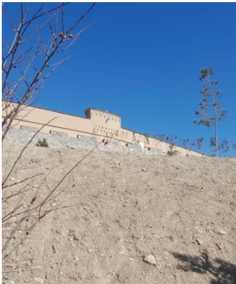
تصویری خارجی از دیوار احاطه قلعه بلند
