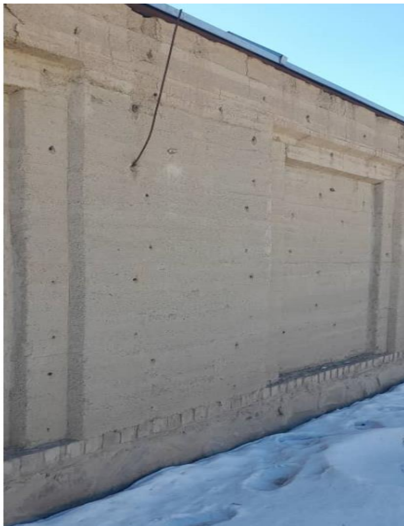
تصویری از دیوار احاطه قسمت سمت جنوب
