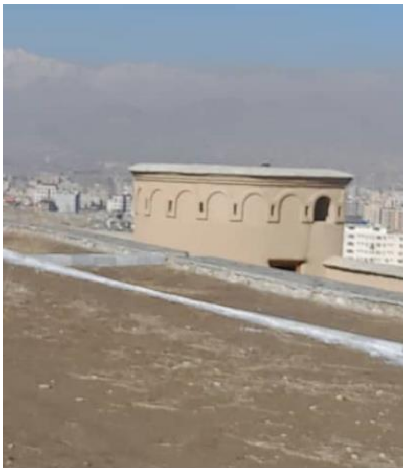
تصویری از قسمت بیرونی برج داخلی قلعه
