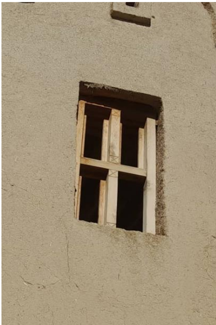
تصویری از قسمت برج های داخلی قلعه
