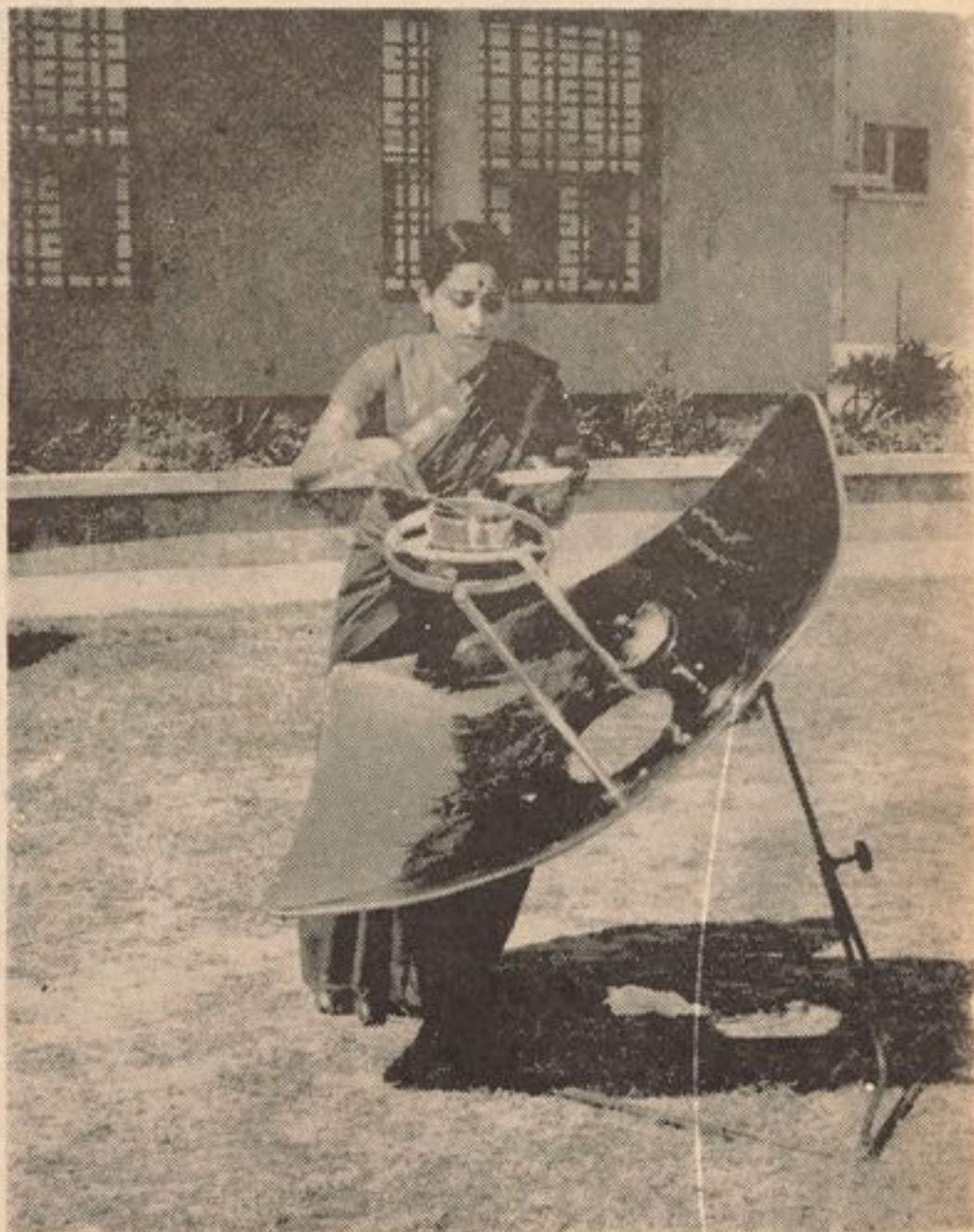
این دستگاه ساده از انعکاس حرارت آفتاب میتواند دیک غذای يك خانواده را پخته کند
