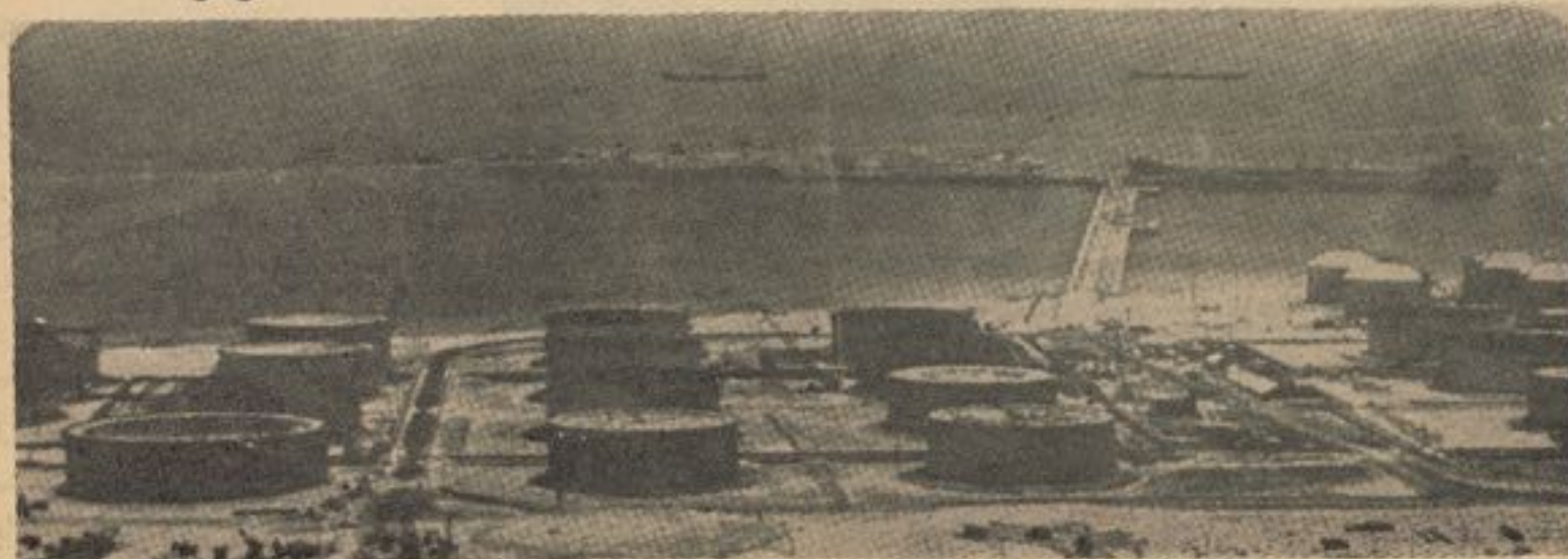
دمنځني ختيځ دتيلو د تصفيه خانه يوه منظره
