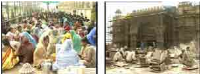
زنان در یک سو مشغول نقش اندازی بر سنگ و کارگرانی در سوی دیگر قطعاتی را برای کف سازی آماده می کنند.
