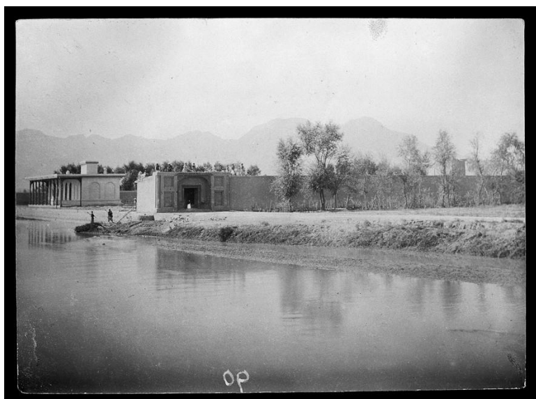
بگرامی - شرق کابل
