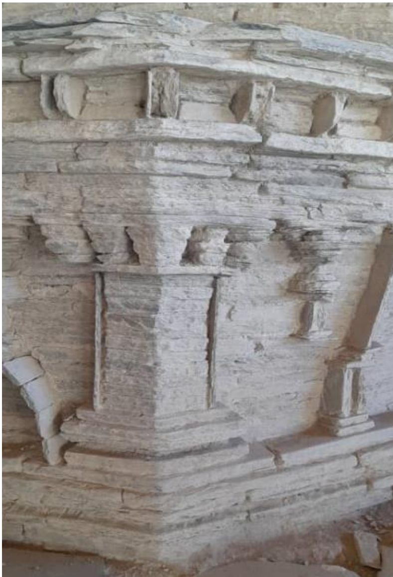
تصویر بخشی از استوای منطقه مس عینک
