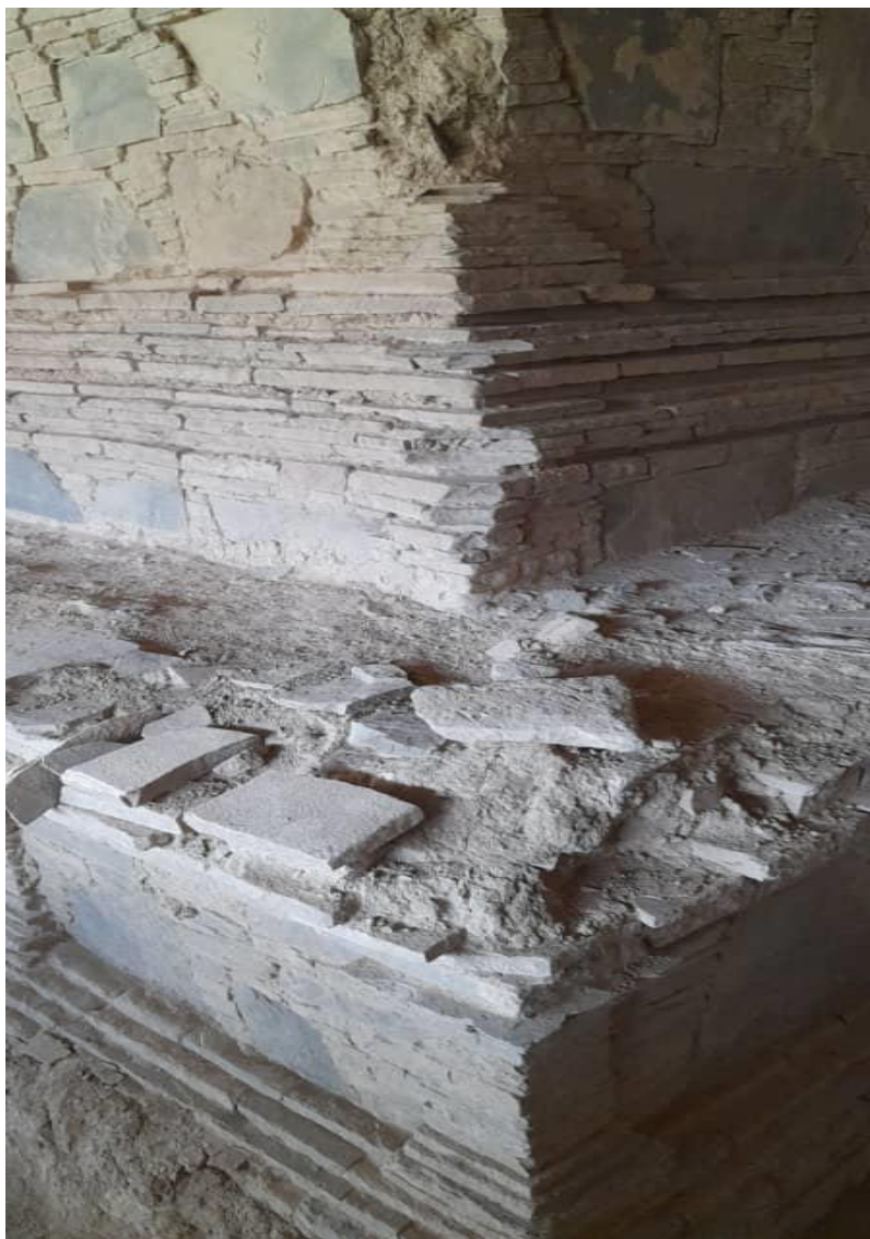
تصویر بخشی از استوای منطقه مس عینک
