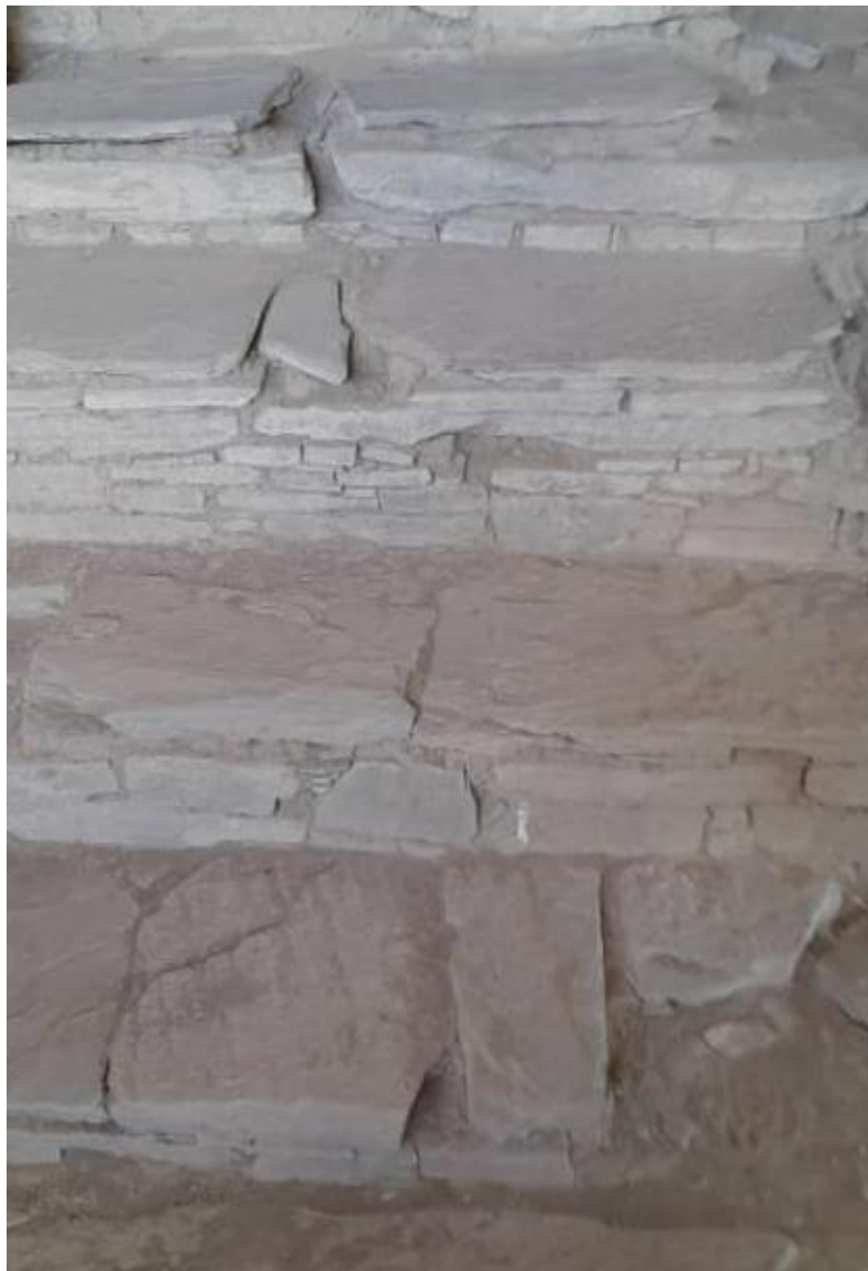
تصویر بخشی از استوپیای منطقه مس عینک
