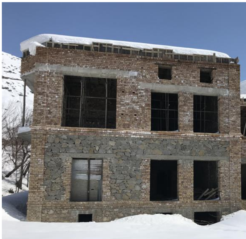
تصویری از قصر حرمسرا در جریان ساختمان
