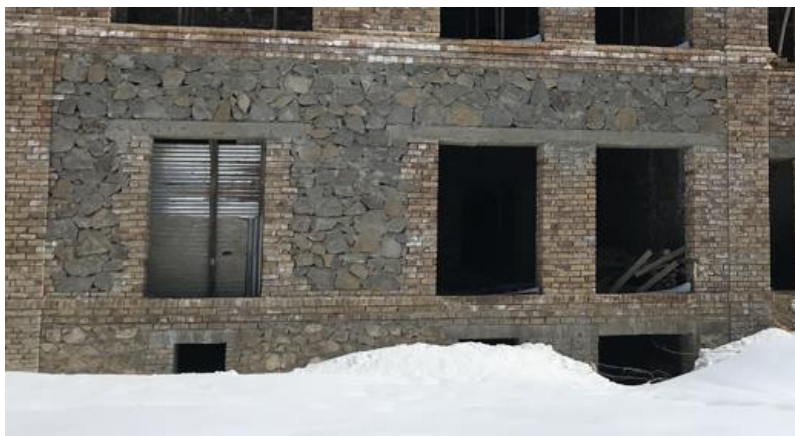
تصویری از قصر حرمسرا در جریان ساختمان
