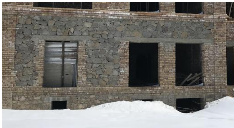
تصویری از قصر حرمسرا در جریان ساختمان
